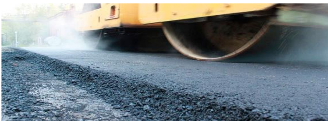
Дорожное строительство (геосинтетика, асфальтобетон)
